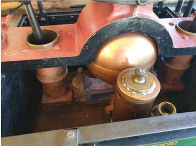
Pumpwerk – saugseitig – Ventile in Einzelkammern, Saug- Umstellhebel abgebrochen
